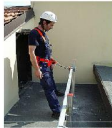
شکل ۴-۵۴ محدودکننده با اتصال یک ریل مخصوص
