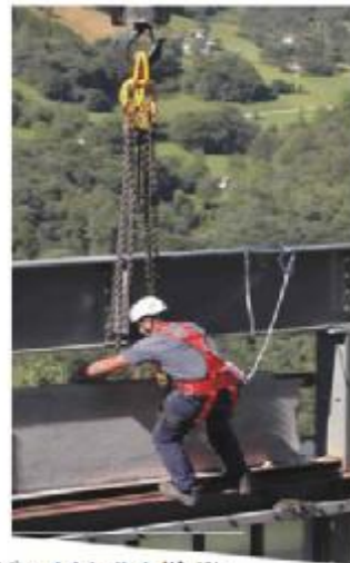
شکل ۷۵- استفاده از ابزار منوقف‌کننده در اجرای سازه طری
