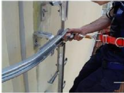
اشکال ۱۱۱- سایانه محدودکننده با استفاده از ریل
