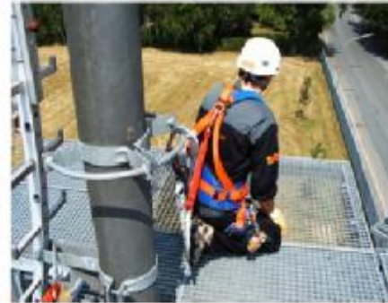
اشکال ۱۱۱- سایانه محدودکننده با استفاده از ریل
