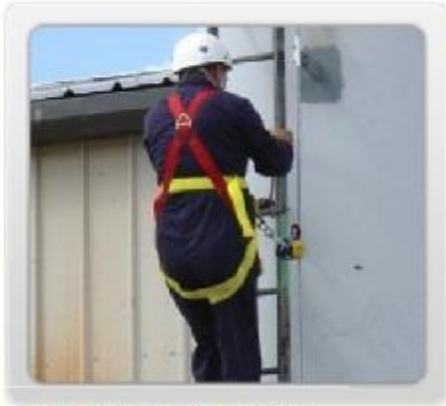
شکل ۷۶- صعود از نردبان با ابزار متوقف‌کننده
