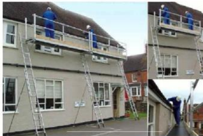
شکل ۳۲- جایگاه کار با استفاده از نردبان
